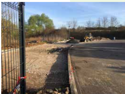
Déchèterie de Wasselonne
